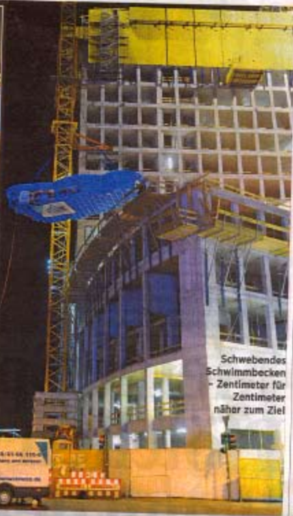
Der riesige 80 000-Liter-Pool wird per Tieflader (li.) angeliefert, hat nach drei Stunden die Endposition (oben) in der 5. Etage erreicht
