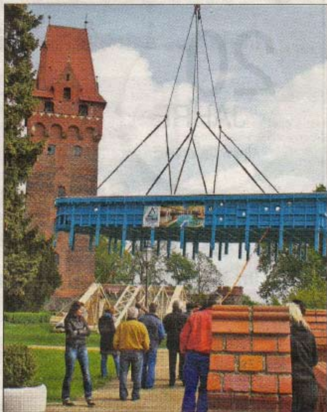
Mit einem Kran wurde das Schwimmbecken von der Promenade aus auf den Burgberg transportiert. Foto: Krach
